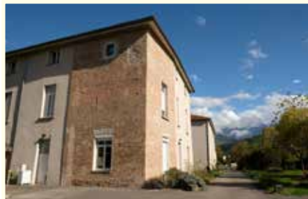
Tour restaurée de l'ancien château fort de la plaine
