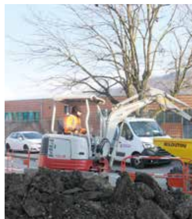
Les travaux de désimperméabilisation de la rue Henri Wallon préparent l'arrivée de 51 arbres.
