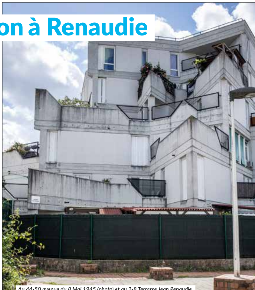
Au 44-50 avenue du 8 Mai 1945 (photo) et au 2-8 Terrasse Jean Renaudie, les travaux de réhabilitation vont démarrer en septembre.
