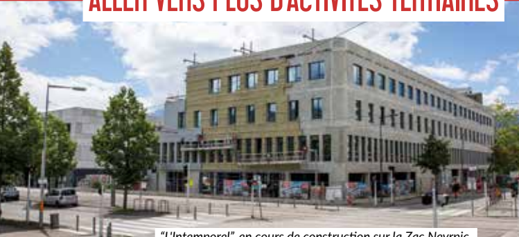
"L'Intemporel", en cours de construction sur la Zac Neyrpic.
